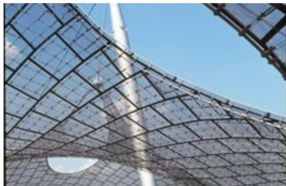
Berechnungsgrundlage beispielsweise für die Stärke der Stahlseile oder der notwendigen Fundamente. An einem maßstabsgetreuen Messmodell wurden Gewichte an die Seile gehängt und die auftretenden Kräfte hochgerechnet. Das transparente Dach wurde im Wettbewerbsmodell mit einem Nylonstrumpf simuliert, das für dessen Bau benötigte Material musste später mit aufwendigsten Untersuchungen
